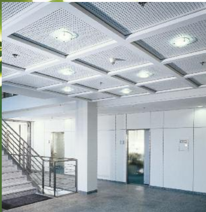
Lochplattendecke mit Einrahmung durch V-Fräsung
