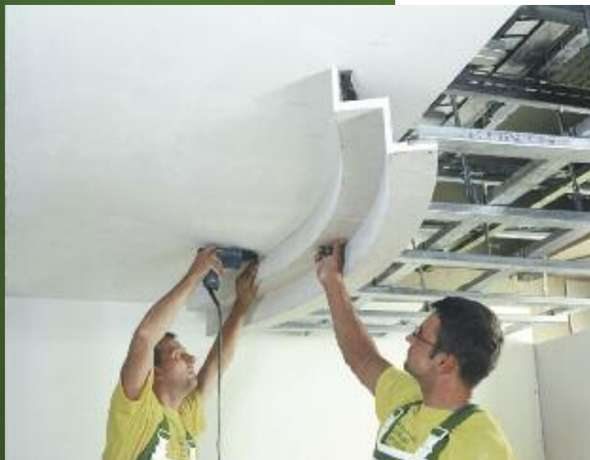
Gebogene Deckenabtreppungen sind exakt auf den gewünschten Krümmungsverlauf vorgefertigt. Sie werden an das UD-Profil der Decke und der Standard-Unterkonstruktion befestigt.
