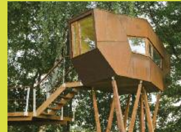
Experiment in Form und Material: oxidierte Cortenstahlfassade, acht asymmetrische, geneigte Eichenstützen
