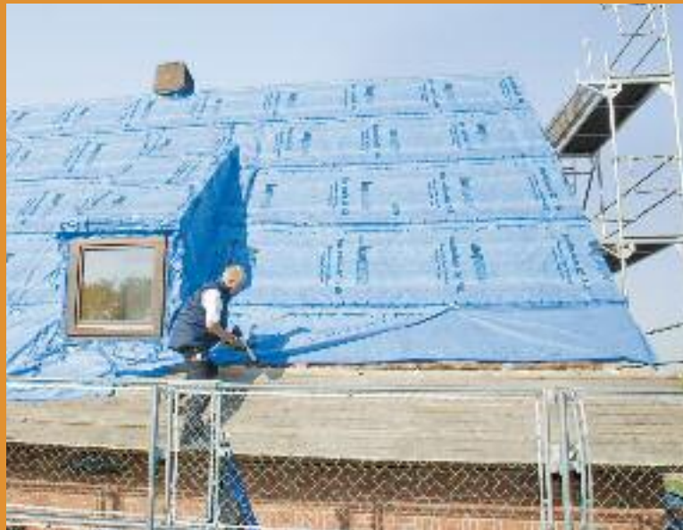
Die Dampfbremsbahn liegt hier plan über den Sparren. Dies spart gegenüber der wannenförmigen Verlegung Zeit.
