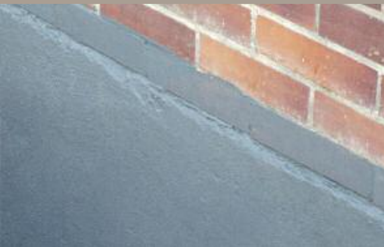
Mineralische Dichtungsschlämme können innen und außen eingesetzt werden
