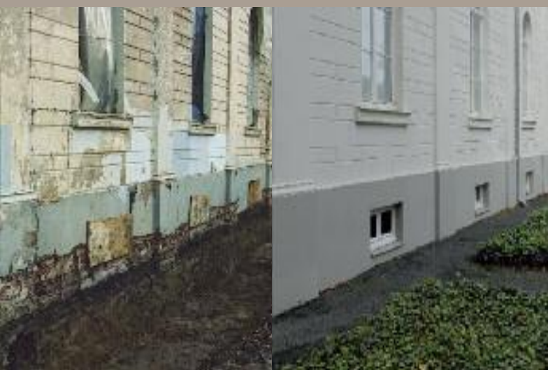
Kaum wiederzuerkennen: das Gebäude nach der Sanierung
