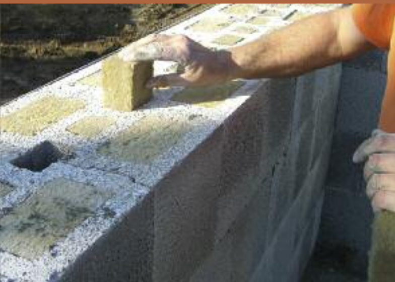
Leichtbetonsteine mit einer Kerndämmung aus mineralischer Steinwolle erfüllen die EnEV problemlos
