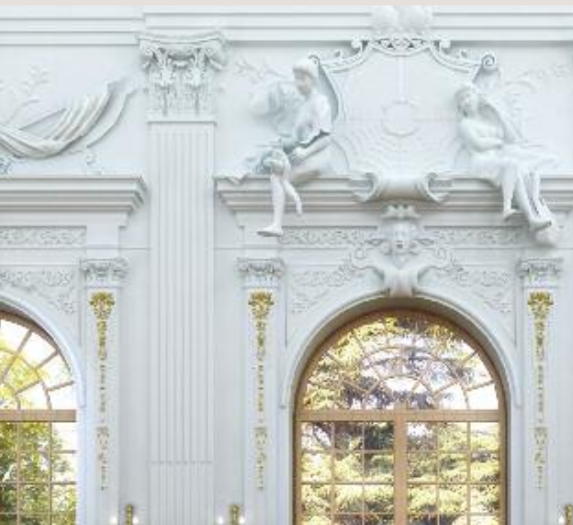
Für prachtvolle Stuckverzierungen wird spezieller Stuckgips (Niederbrandgips) verwendet
