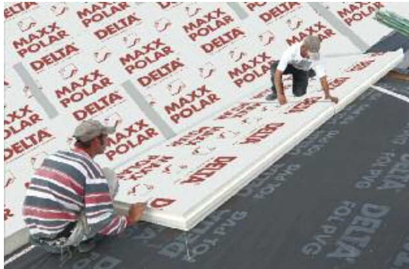
Mit den neuen Aufdach-Dämmelementen Delta-Maxx Polar werden energetisch zukunftssichere Konstruktionen erreicht
