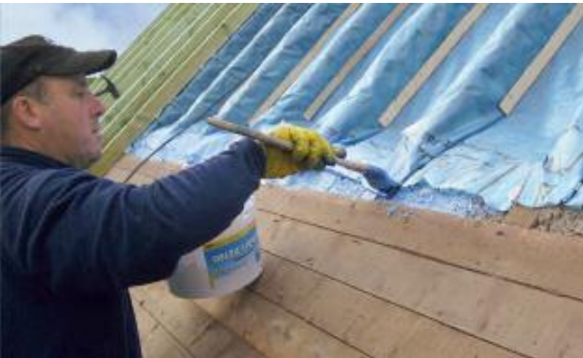
Mit einer speziellen Funktionsbeschichtung können auch komplizierte Anschlüsse der Dampfbremse bzw. Dampfsperre oder auch Details an schwer zugänglichen Stellen sicher ausgebildet werden
